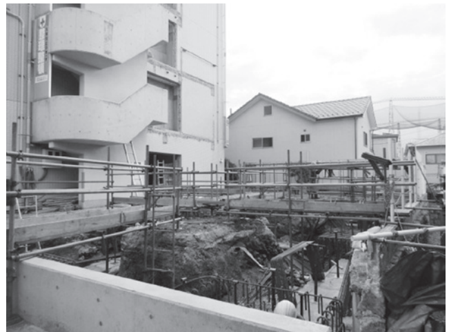
令和元年11月26日からの鉄筋組立工事
