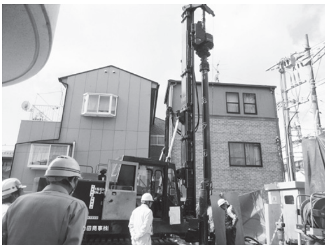
令和元年11月11日からの杭打ち工事
